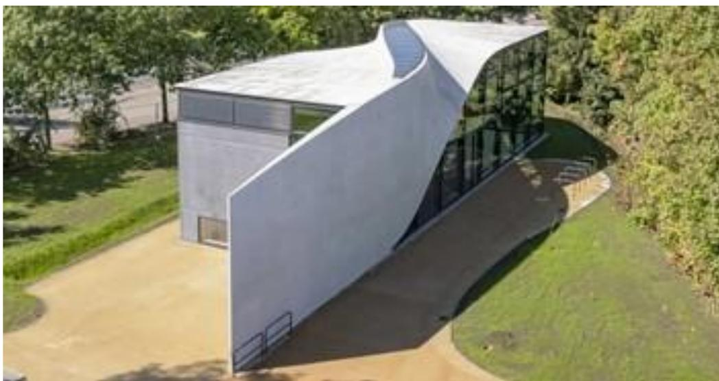
**Рис. 3. Павильон из углебетона [14]**
