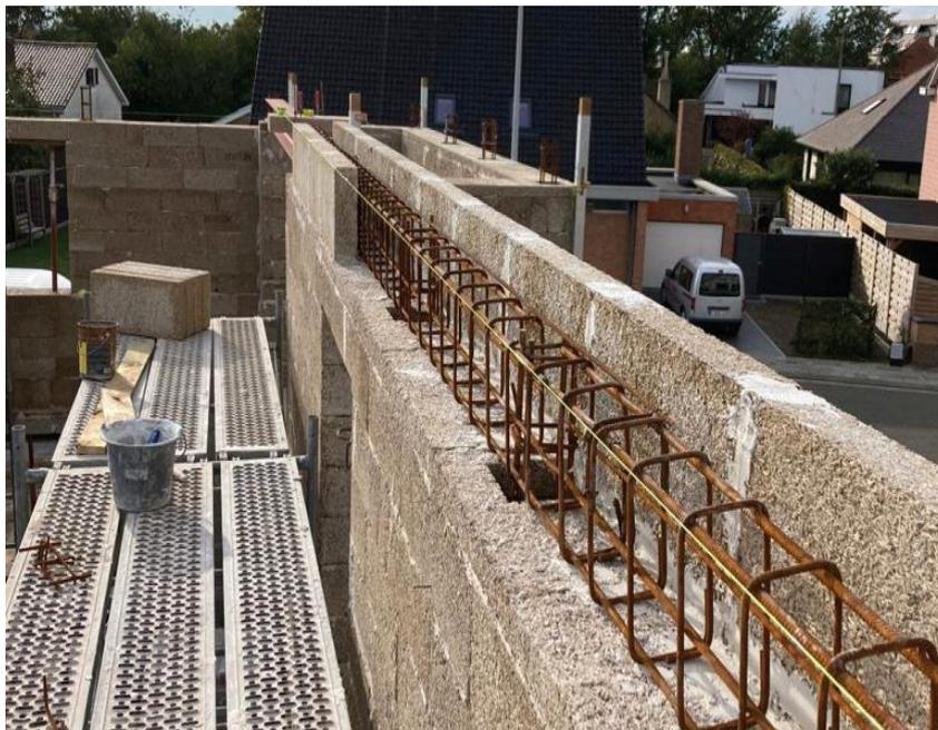
**Рис. 2. Костробетон [7]**
