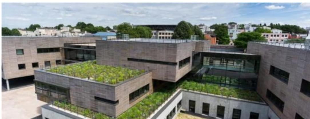
**Рис. 1. Пример кровли с озеленением**
